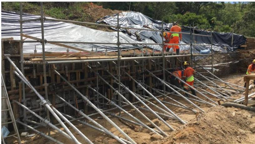
**Foto 13** – Obra de recuperação de talude – Km 15+700 Sul
